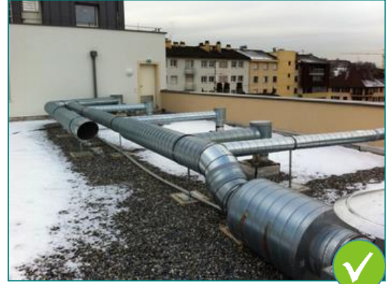
3 : Porte d'accès et cheminement en toiture terrasse
