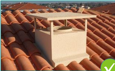
1 : Sortie de toiture correcte
