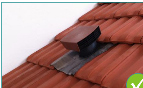
2 : Sortie de toiture correcte
