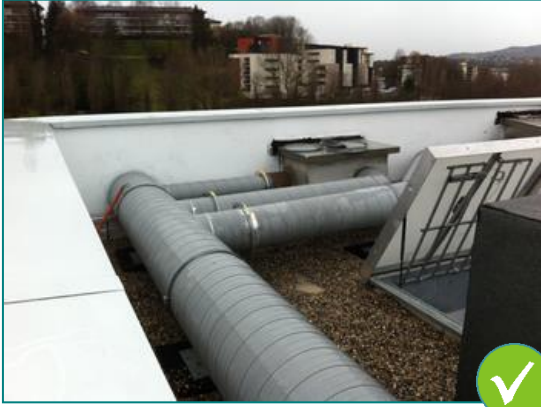
1 : Trappe d'accès à la toiture terrasse
