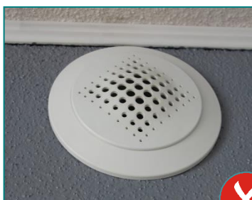
2 : Bouche collée à une paroi
