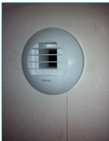
4 : Bouche d'extraction hygroréglable avec cordelette
