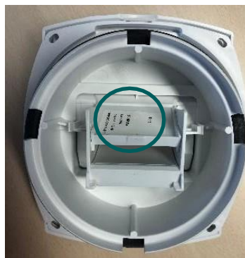
4 : Bouche d'extraction hygroréglable avec cordelette
