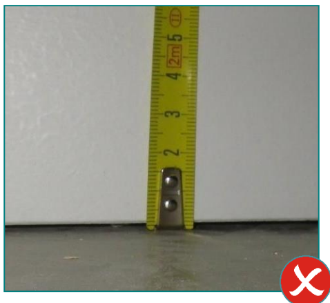
2 : Détalonnage insuffisant
