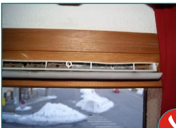
2 : Absence de mortaise derrière l'entrée d'air
