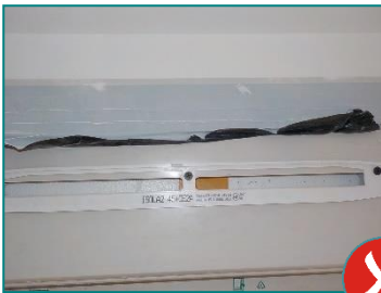
1 : Isolant obstruant complètement la mortaise
